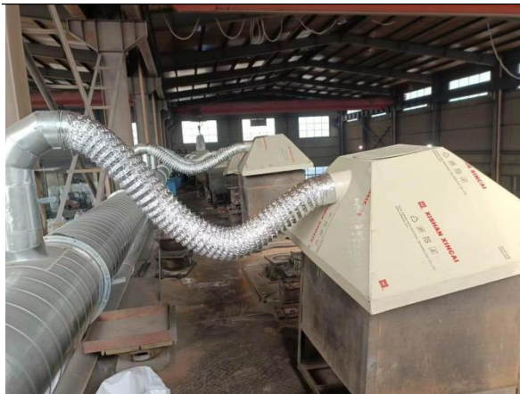
投料工段集气罩收集
