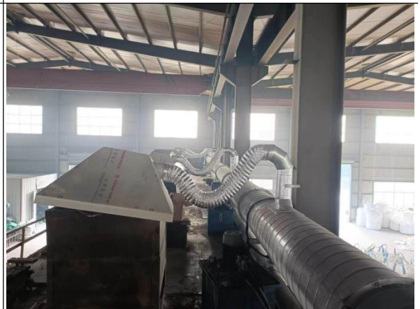
投料工段集气罩收集
