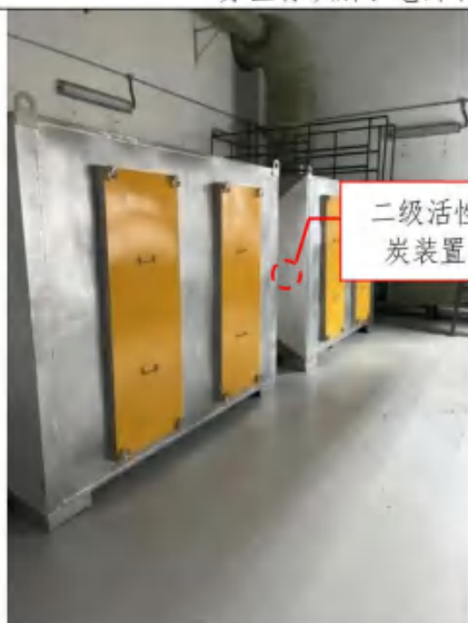
危废仓库配备的二级活性炭吸附装置及 P39 废气排气筒
