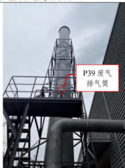
危废仓库配备的二级活性炭吸附装置及 P39 废气排气筒
