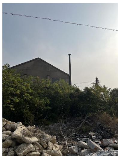
注塑废气排气筒
