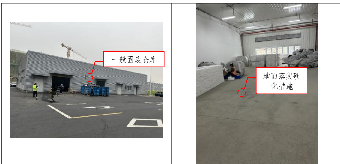
一般固废堆场落实防风、防雨等措施，地面落实硬化。
