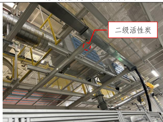
2 条玻璃涂胶生产线各自配备的二级活性炭吸附装置
