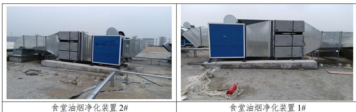
图 4.1-7 该项目废气处理设施、废气监测点位现场照片
