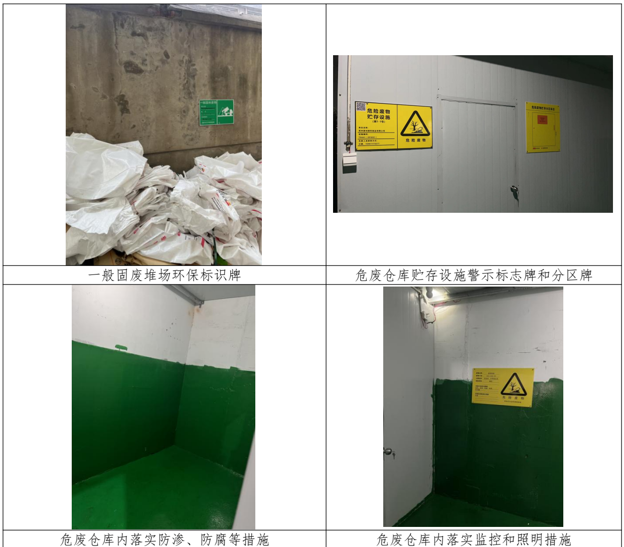
图 3-5 一般固废堆场、危险废物堆场建设情况
