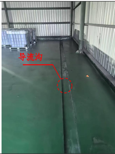
危废仓库地面落实环氧措施，落实防渗、防腐蚀措施；四周设置导流沟，并设置收集池。
